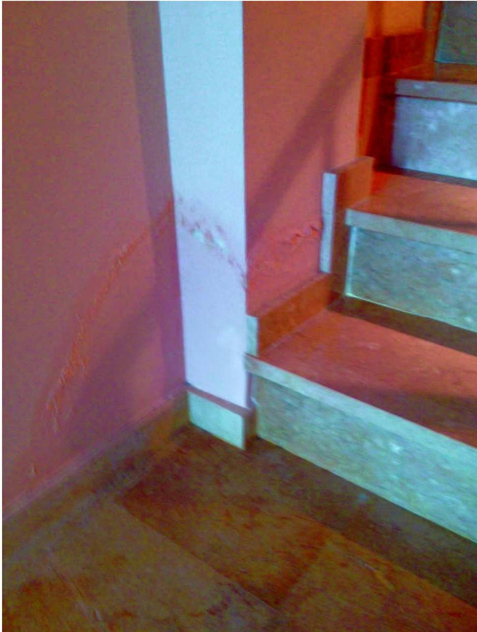
Fotografía 5: Se puede observar una mancha de humedad en la zona de arranque de la escalera interior de la vivienda.
