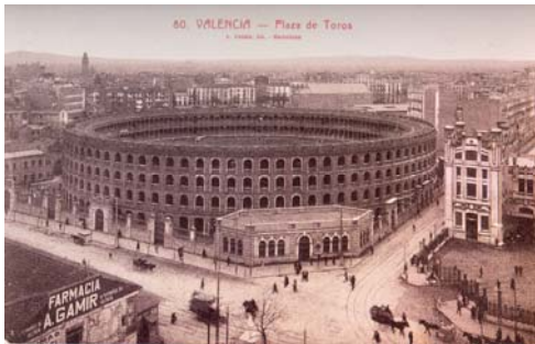
IMAGEN 5: Vista de la Plaza de Toros de Valencia con el café - bar en el chaflán de la parcela.
