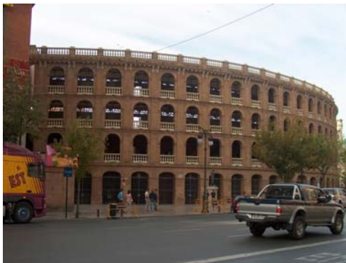
IMAGEN 9: Vista exterior. Plaza de Toros de Valencia.
