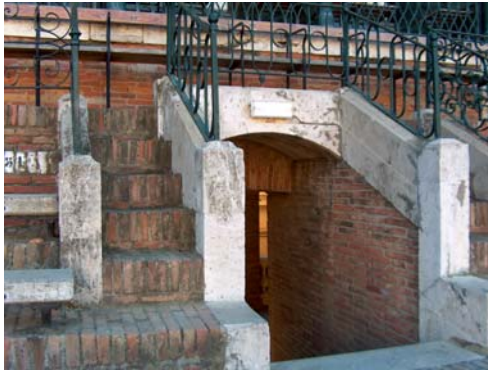
IMAGEN 18: Detalle del vomitorio de acceso al tendido. Plaza de Toros de Valencia.
