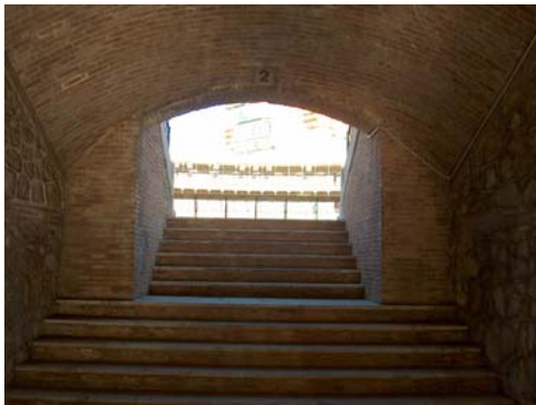
IMAGEN 15: Detalle del acceso al tendido. Plaza de Toros de Valencia.
